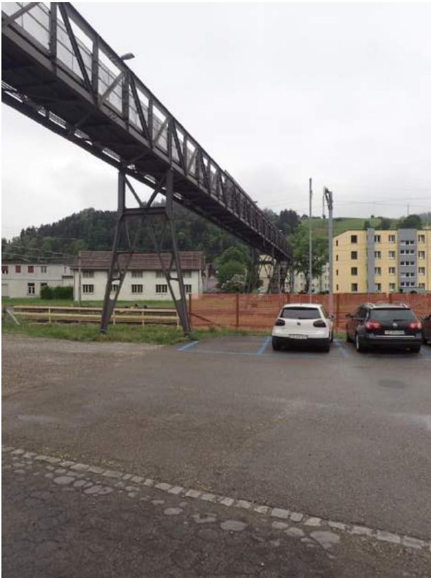
Pendelstütze „rechts“ im Vordergrund
